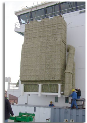
Installation einer Entschwefelungsanlage
