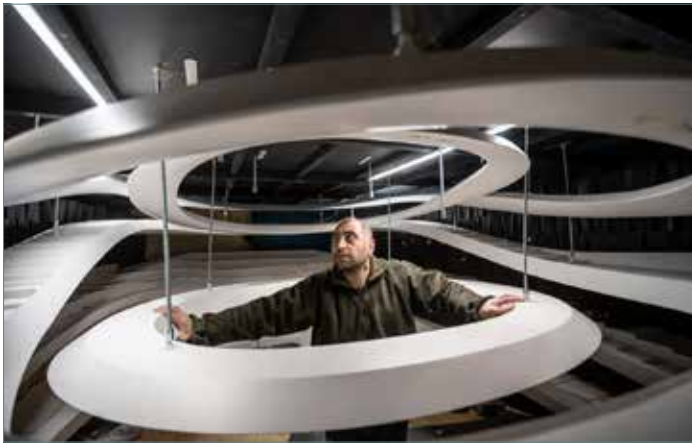
Ausrichtung der Deckenreflektoren. Foto: Wojtek Radwański
