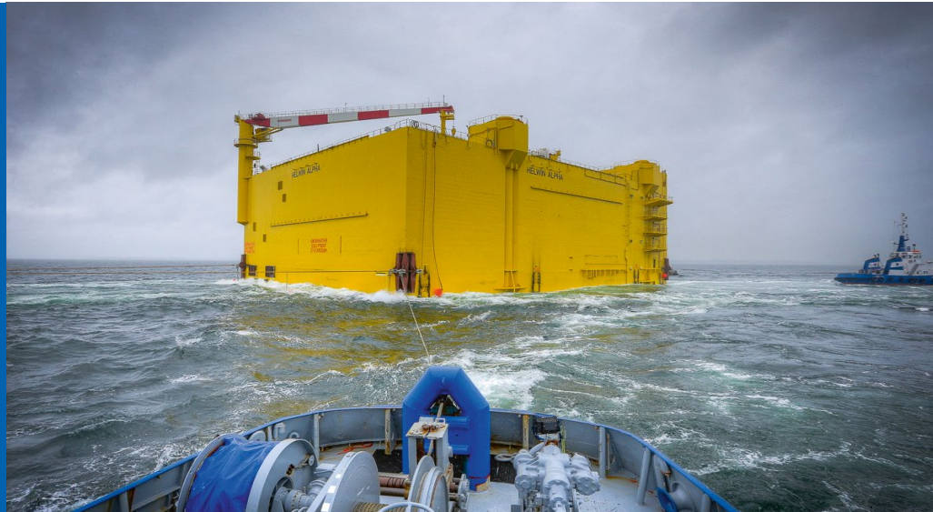
Transport einer Umformerplattform Quelle: Siemens AG, Fotograf: U. Wirrwa
