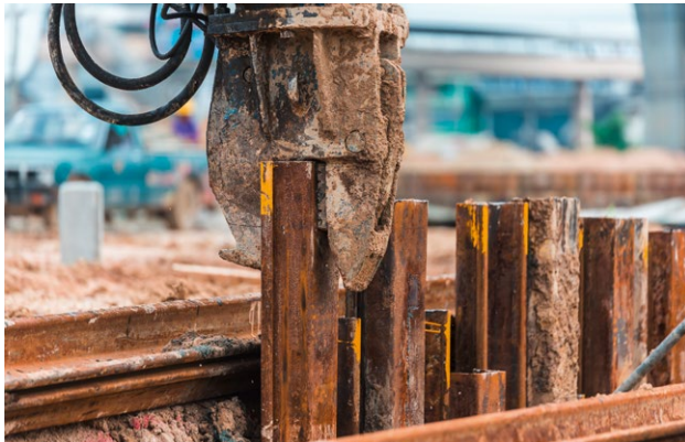
Spundwandaarbeiten können zu hohen Erschütterungsimmissionen führen (Kokliang/Shutterstock.com)
