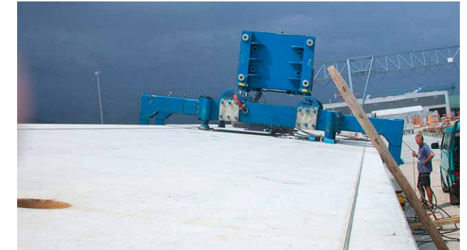
Befestigung des DYNAQ® auf einer Gleisplatte
